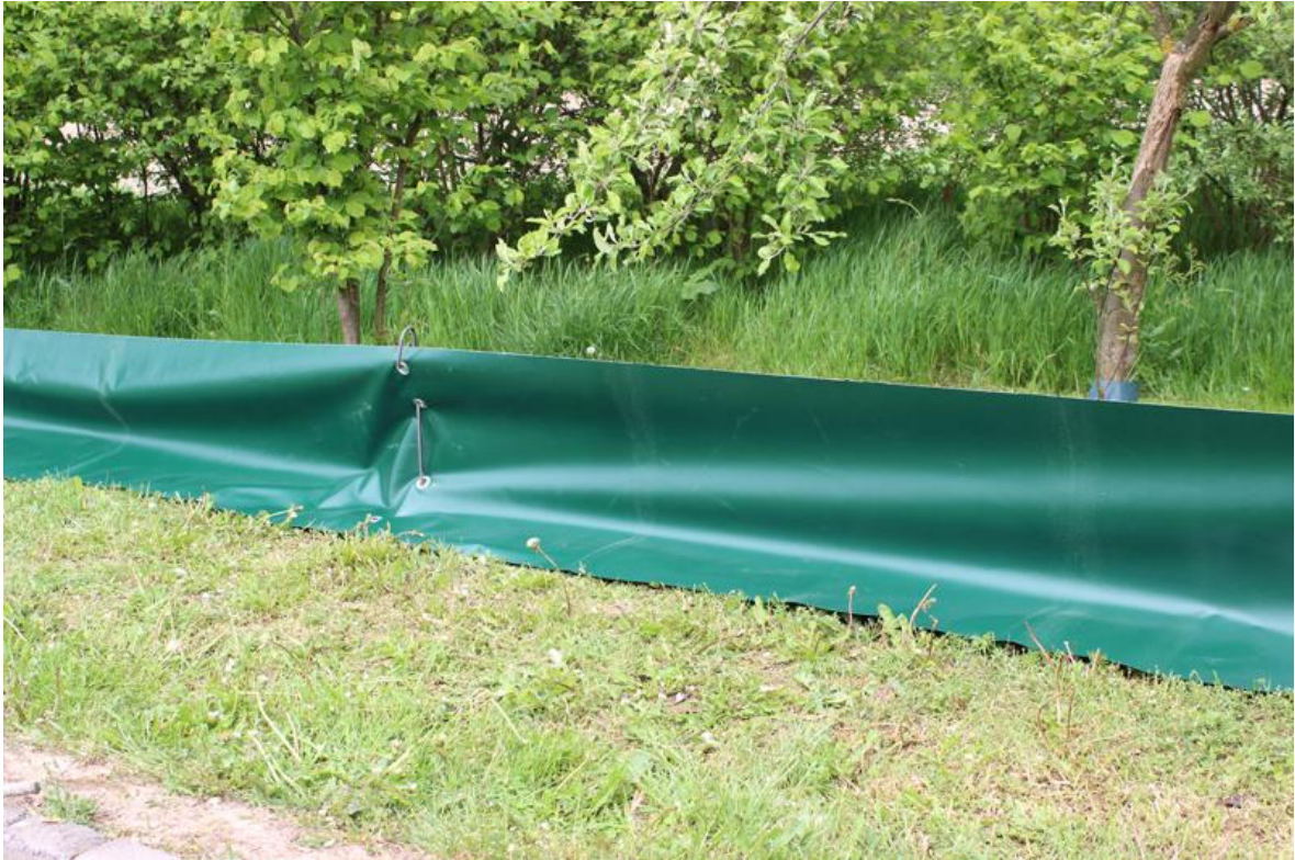
Abb. 11: Beispiel für Reptilienschutzzaun aus hochreifester (Lkw)Plane (Materialstärke ca. 650 \text{ g/m}^2 ). Anders als im Beispiel dargestellt ist das untere Ende ca. 10 – 20 cm tief in den Boden einzugraben. Bei der Verwendung von Folie statt einer Plane wird eine Materialstärke von mind. ca. 250 \text{ g/m}^2 empfohlen, das Material sollte eine glatte Beschichtung und eine Höhe von ca. 0,5m – 1m aufweisen.
