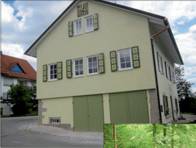
Die Sanierung des "Alten Schulhauses" in Lehenweiler wurde in diesen Tagen abgeschlossen.
