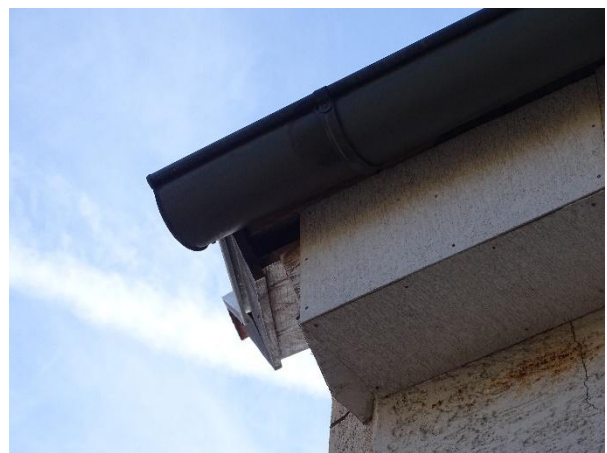
Spalten am Gebäude der Badstraße 12 stellen potenzielle Tagesquartiere u.a. Zwergfledermaus dar.
